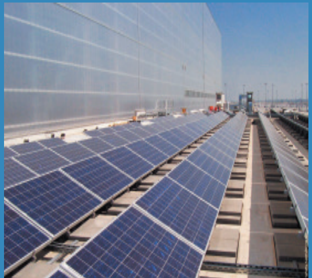
0,12 MWp DHL , Leipzig 600 Module SOLARWATT P210-60 GET AK
