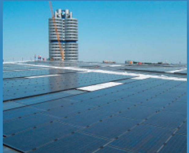
0,8 MWp BMW- Welt München 3.600 Module SOLARWATT P220-60 GET AK
