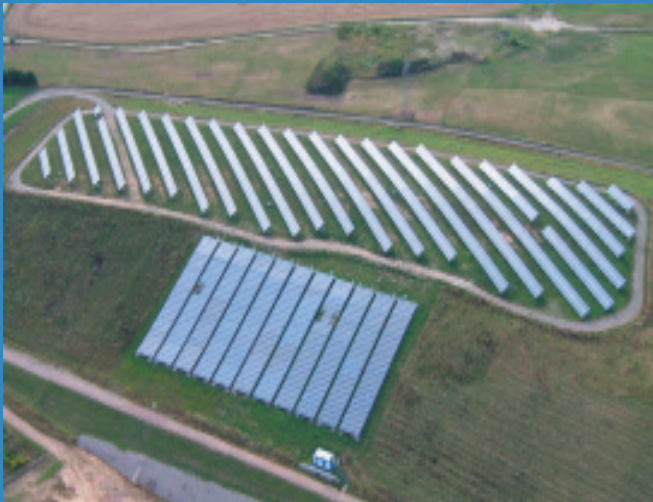
1,1 MWp Chemnitz, Wittgensdorf 5.376 Module SOLARWATT P210-60 GET AK
