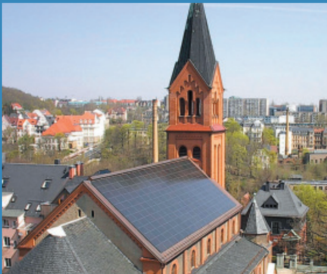
Dachintegration roof integration Intégration en toiture
