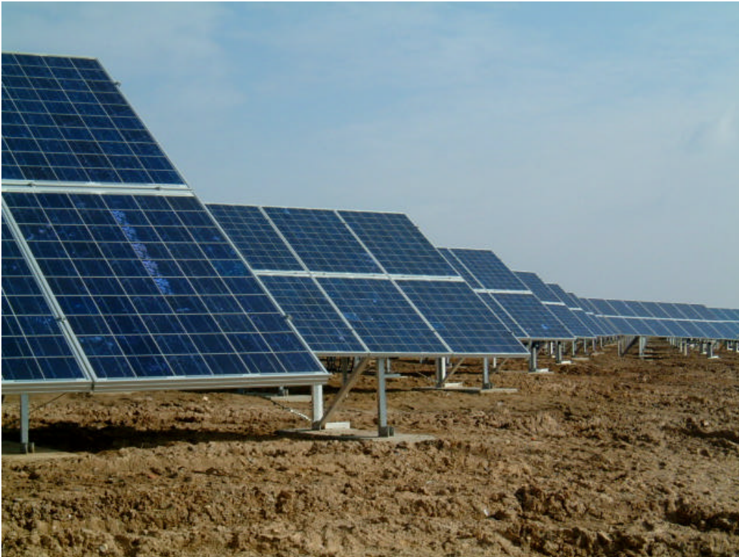
Aufständigung PV-Module
